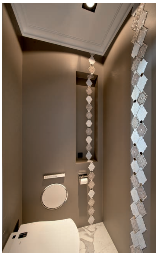
Tegelwerk als detail. Zeer nauwkeurig snijwerk in het stucwerk en schilderwerk zorgen voor extra accentuering. (foto: Jan Willem Kommer)
